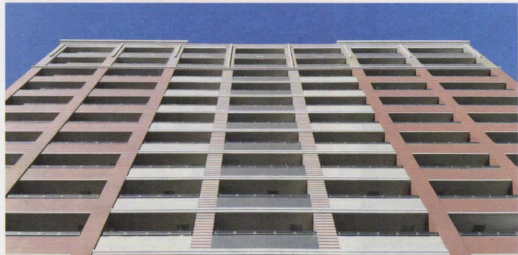
マンションの配管は給水管なら25年、配水管なら35年程度で水漏れが起こるようになる (写真はイメージ)
